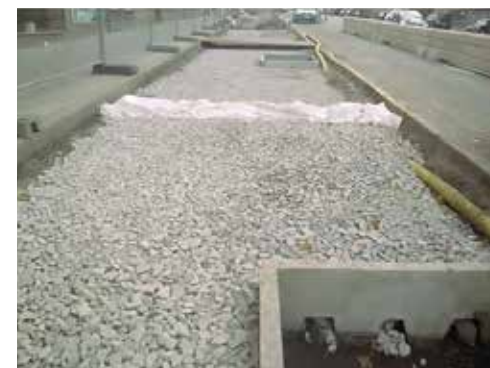
Dämmen av geotextil i luftigt bärlager.
