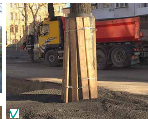
Träd skyddat med täckmatta och brädor vid växtbäddrensning. Foto Lovisa Hell.
