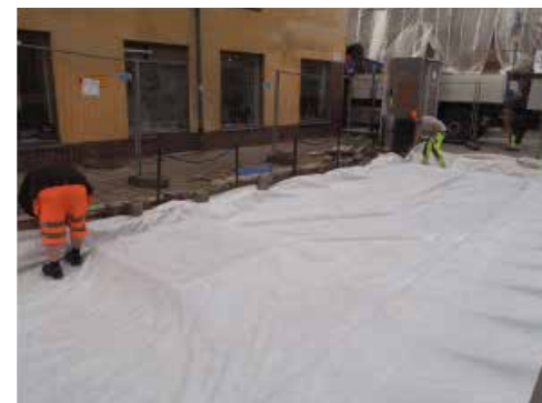
Geotextil breddas ut över avjämningslagret och hela växtbädden. Det är viktigt att geotextilen viks upp mot trädgropsfundament, brunnar och kantsstöd för att förhindra att obundet bärlager blandas med luftigt bärlager.
