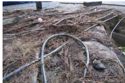
Rötter och ledningar konkurrerar om utrymmet under mark.
