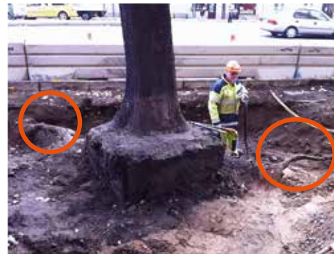
Pipelinerötter som blottagts vid schakt.
