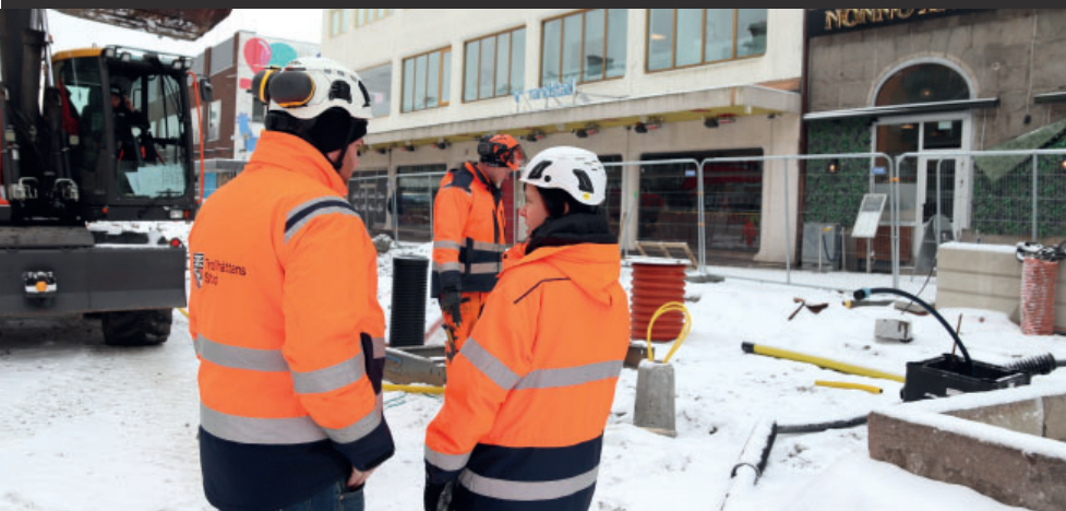
Projektledaren Susanna Wallin från samhällsbyggnadsförvaltningen och platschefen Thomas Magnusson från serviceförvaltningen är mycket nöjda över samarbetet i projektet.
