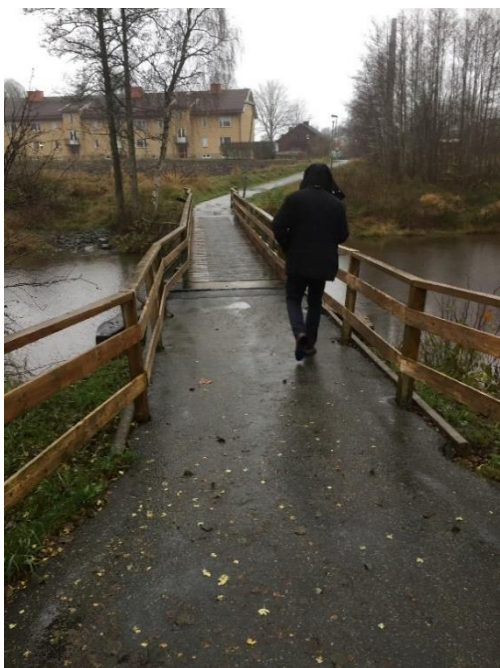
Bild 1. GC bro Slumpåvägen
