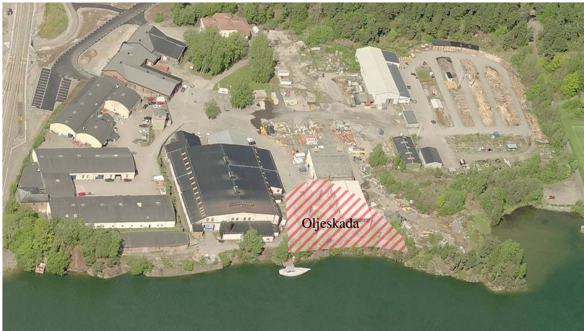
Figur 5 Lokalisering av oljeskada.
