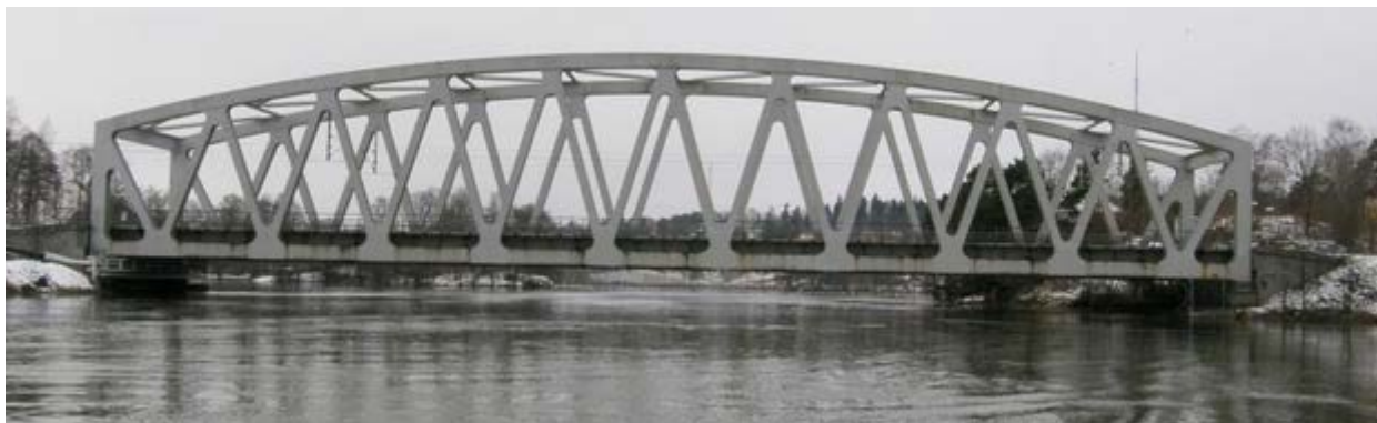
Figur 4 Fackverksbro för järnväg i Trollhättan
