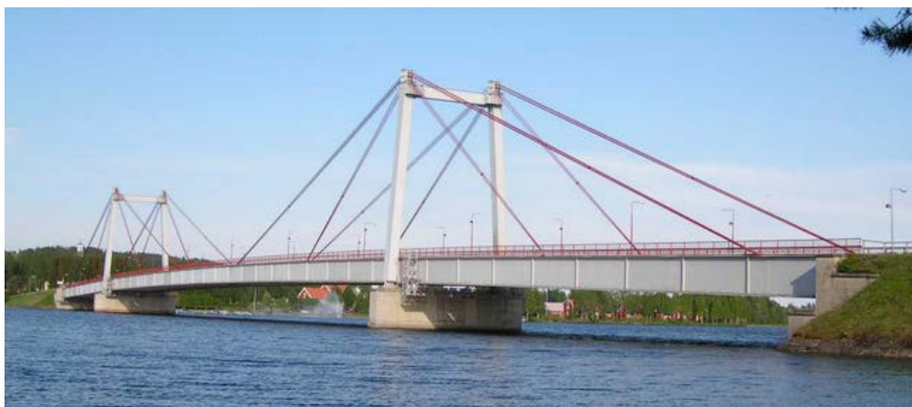
Figur 7 Exempelbro från Strömsund
