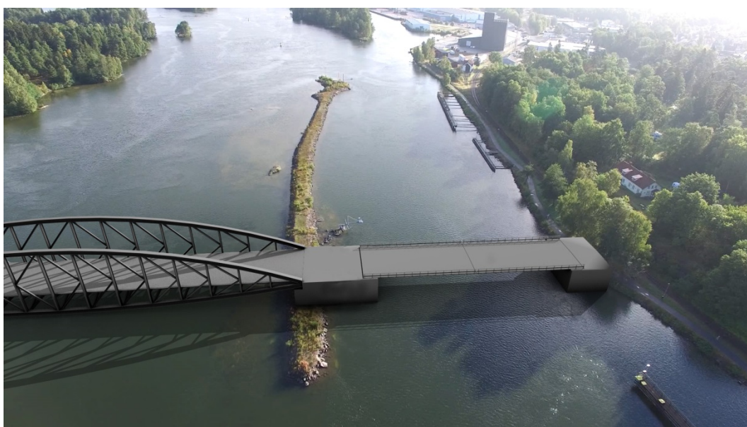
Figur 9 Dubbelklaff i kombination med fackverksbro
