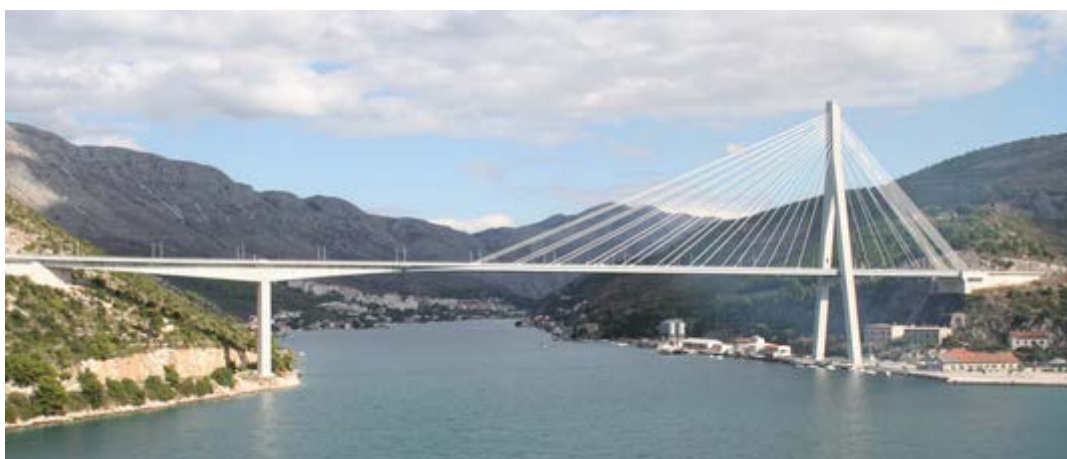
Figur 8 Ensidig snedkabelbro i Dubrovnik
