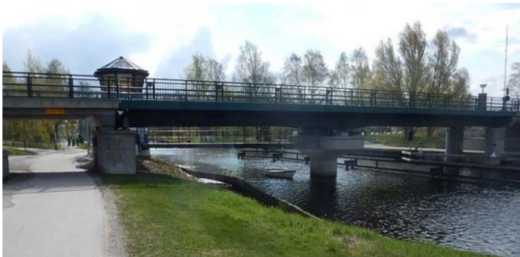
Figur 12 Exempel olikssidig svängbro, Skebäcksbross
