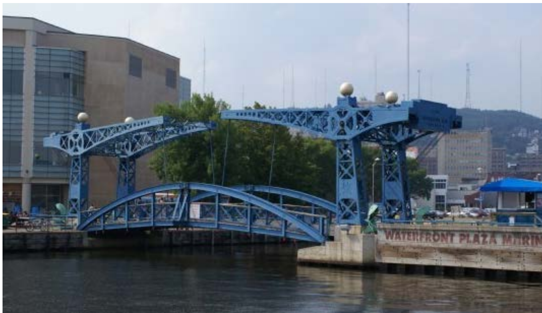
Figur 10 Exempel dubbel Holländsk klaff
