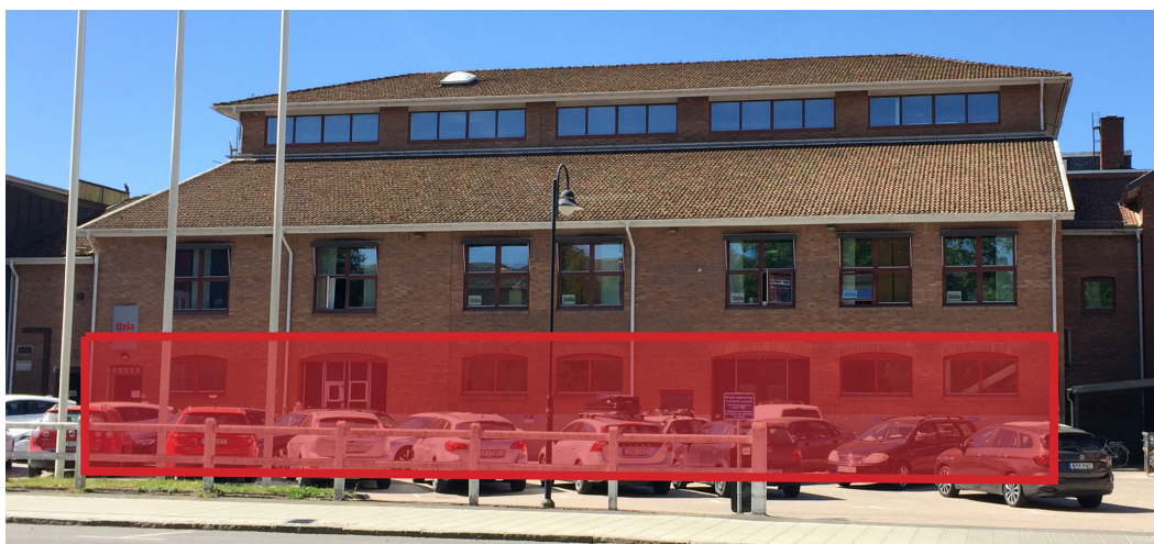
Plan 1 i befintlig byggnad Rödjan 8 (markerat i rött) som endast får användas för parkeringsgarage, förråds- och teknikutrymmen.. Det regleras med planbestämmelse s2 i plankartan.
