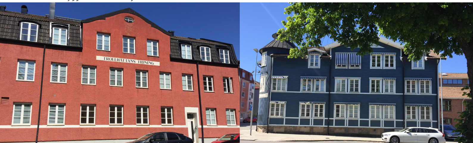
Byggnader inom Rödjan 5
