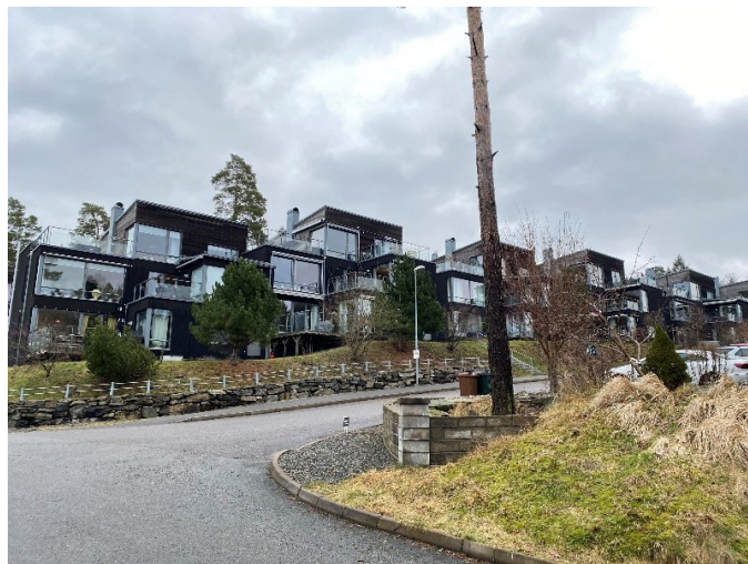
Figur 34. Bebyggelse som följer gata och topografi. Kedjehus i Nysäter, Mölnlycke (Foto: Norconsult)
