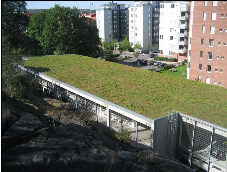
Figur 17. Exempel på utförande med sedumtak på parkeringsdäck (Vegtech 2006).
