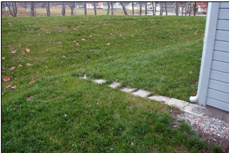
Figur 16. Exempel på ytlig avledning av takvatten mot nedsänkt yta via stuprörsutkastare (SVOA u.å.).
