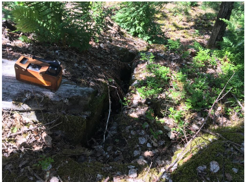
Figur 12 Brantstående öppen spricka i nordvästlig-sydöstlig riktning. Mätinstrumentet (Scintillometern) är omkring 30 cm lång.
