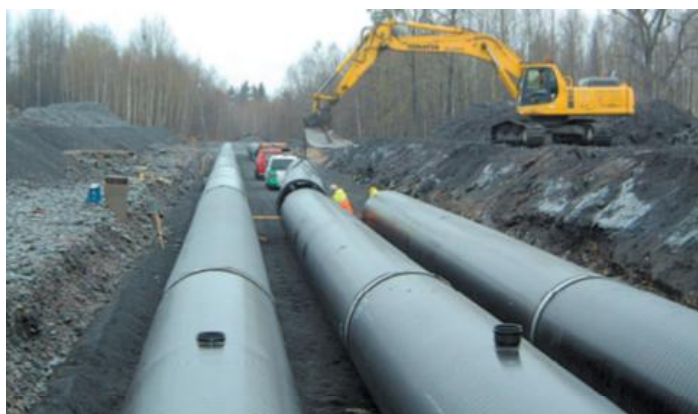
Figur 28: Exempelbild på dagvattenmagasin av plast. Fotot visar Weholite dubbelväggiga lättviktsrör i polyeten. Källa: www.kwhpipe.se
