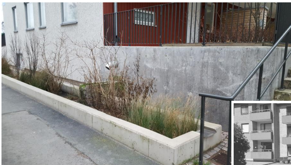
Figur 31: Ovan visas en exempelbild över avvattning från innergård till växtbädd i gata på Hisingen, Göteborg. Foto: Ramböll
