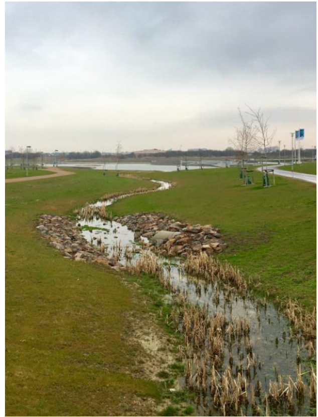
Figur 22: Meandrande dike med utlopp i dagvattendamm belägen i Råby Sjöpark, Lund. Foto: Ramböll
