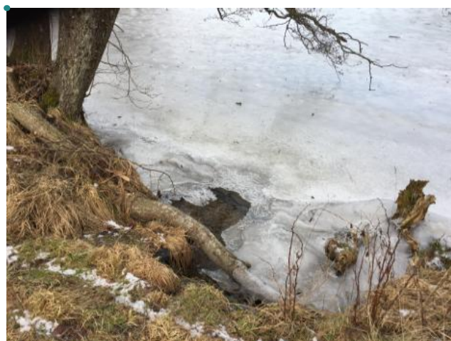
Figur 8: Utlopp dräneringsledning under fotbollspan i delområde C.
