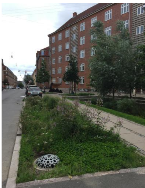
Figur 27: Exempelbild växtbädd med bräddningsfunktion till dagvattenbrunn med kupolsil belägen vid Tåsinge Plads, Köpenhamn. Foto: Ramböll
