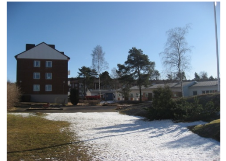
Flerbostadshus med komplement av radhus längs Karlstorpsvägen, norr om planområdet.
