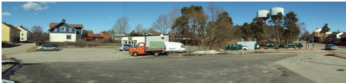
Planområdet med befintlig bilverkstad, återvinningsstation och trädunge samt med omgivande bostadsbebyggelse
