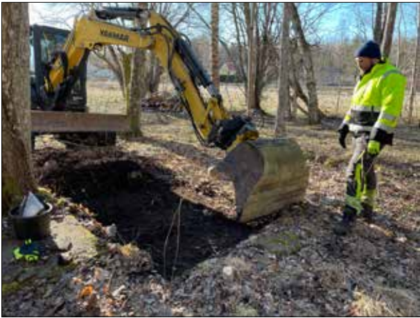
Figur 11. Arbetsbild från undersökningen. Philip Blomqvist övervakar schaktning vid husgrunden. Foto: Anna Beckman.
