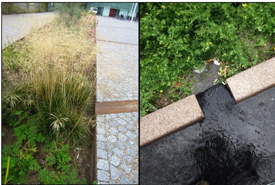
Figur 10. Exempel på nedsänkt växtbädd och utformning av kantsten för tillrinning av dagvatten. Bildkälla: NIRAS.
