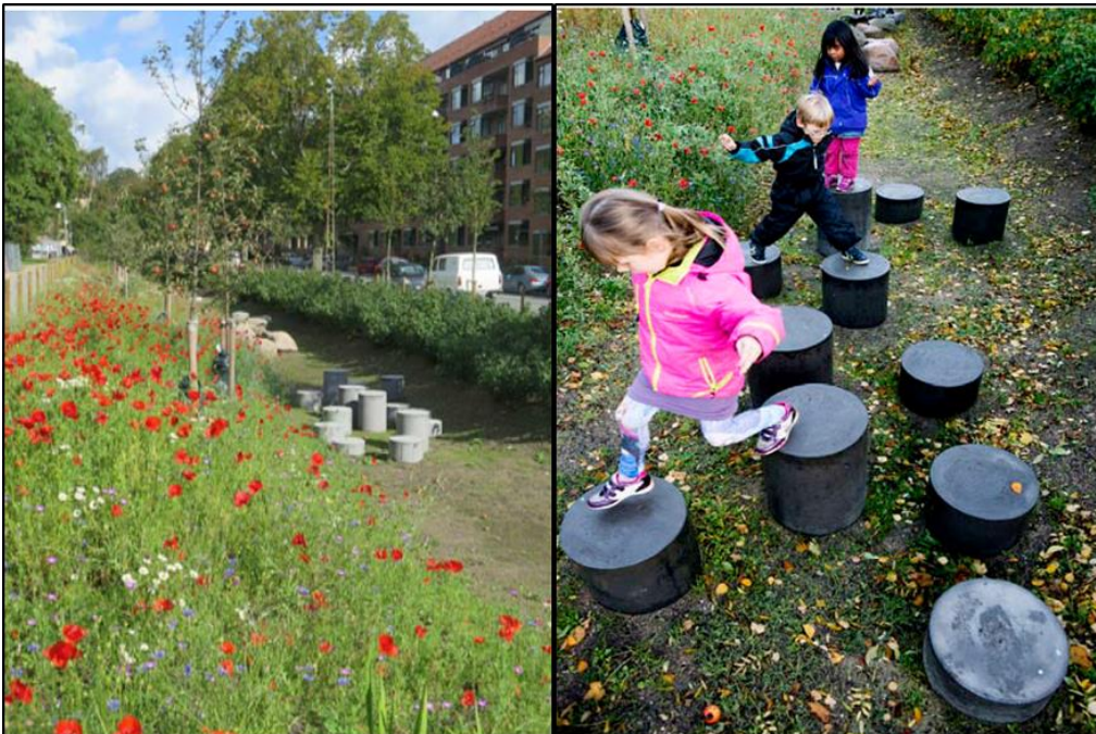
Figur 13. Exempel på svackdike utan vatten, som utformats för lek. Bildkälla: NIRAS.
