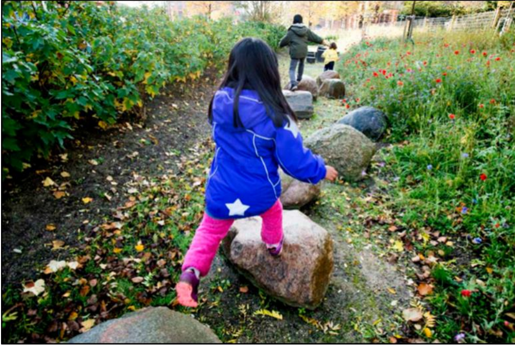
Figur 12. Exempel på svackdike utan vatten, som utformats för lek. Bildkälla: NIRAS.
