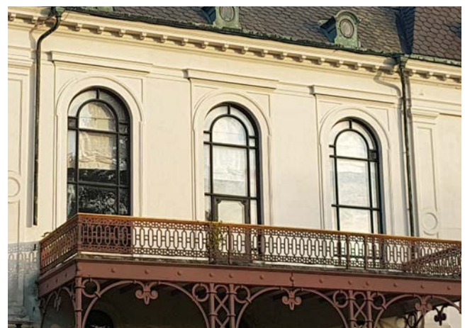
Det övre planet har rundbågade fyrlufts-fönster med förhöjd tvärpost. Stora fönster med rundbåge vid balkongen i gjutjärn mot trädgårdssidan.
