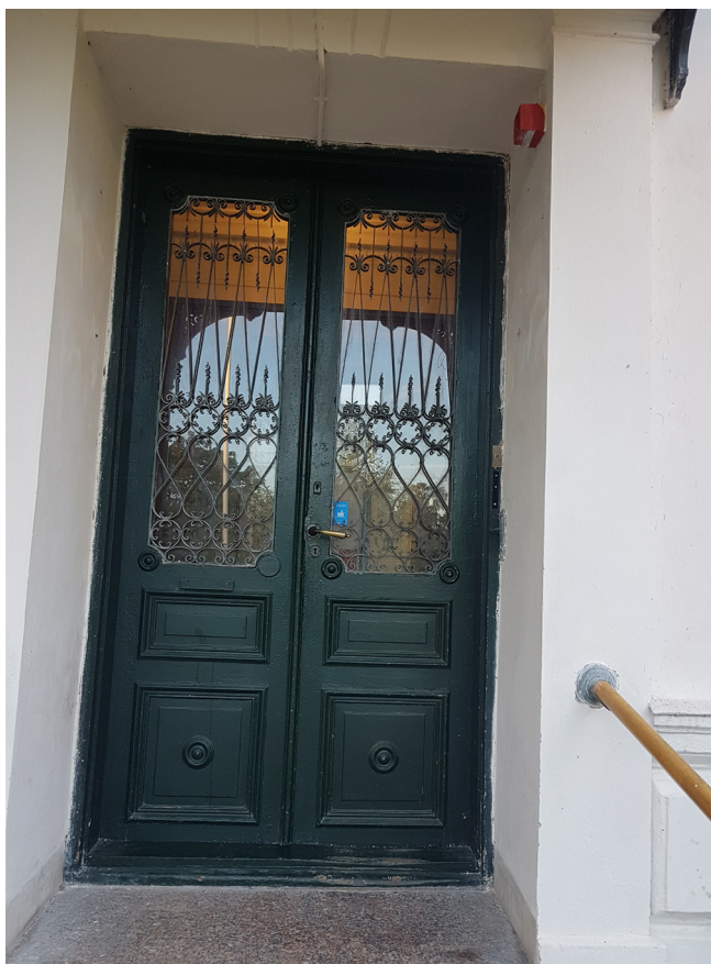
Porten är en pardörr i massivt trä med glasade partier som är försedda med rikt utsmyckat gjutjärnsgaller.
