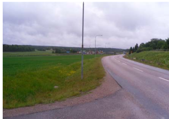
Väg, yta för framtida tågstopp samt ny bro i bakgrunden sett från Stigtomtsvägen
