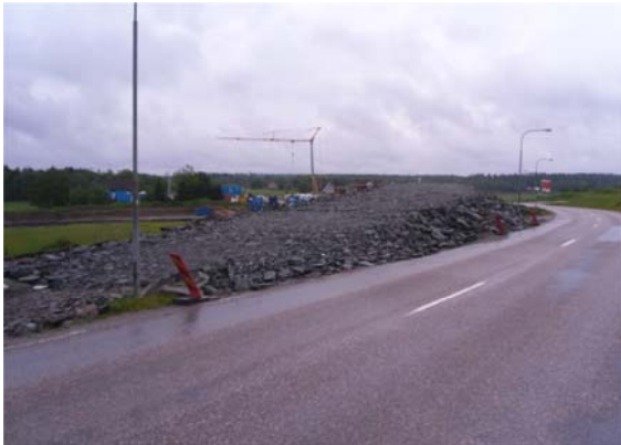
Ny vägbro byggs över den nya järnvägen.
