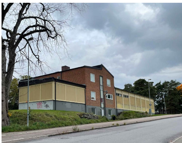
Bild 27 Befintlig byggnad, fasad mot Göteborgsvägen. Bild från Arkitekterna Krook och Tjäder.
