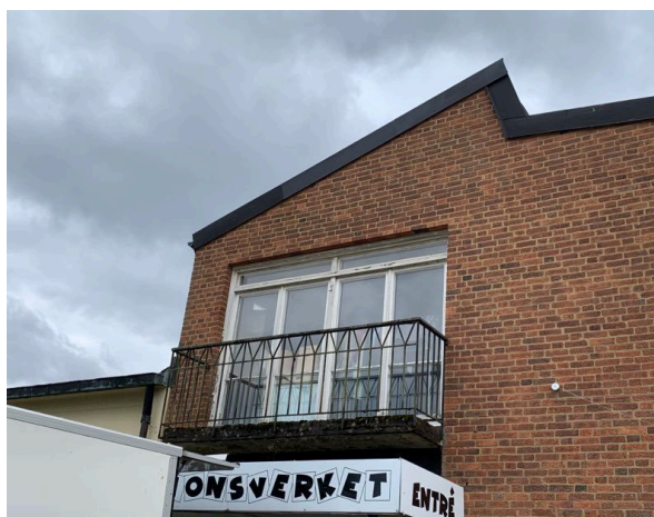
Bild 28 Befintlig byggnad, detaljer så som smidesräcke och markerad takfot.
