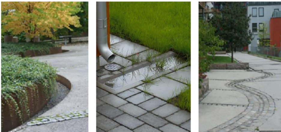
Figur 13. Exempel på utformning av dagvattenrännor i urban miljö. Det högra och vänstra exemplet är foton från Sweco, exemplet i mitten kommer från S:t Eriks rännalsplattor
